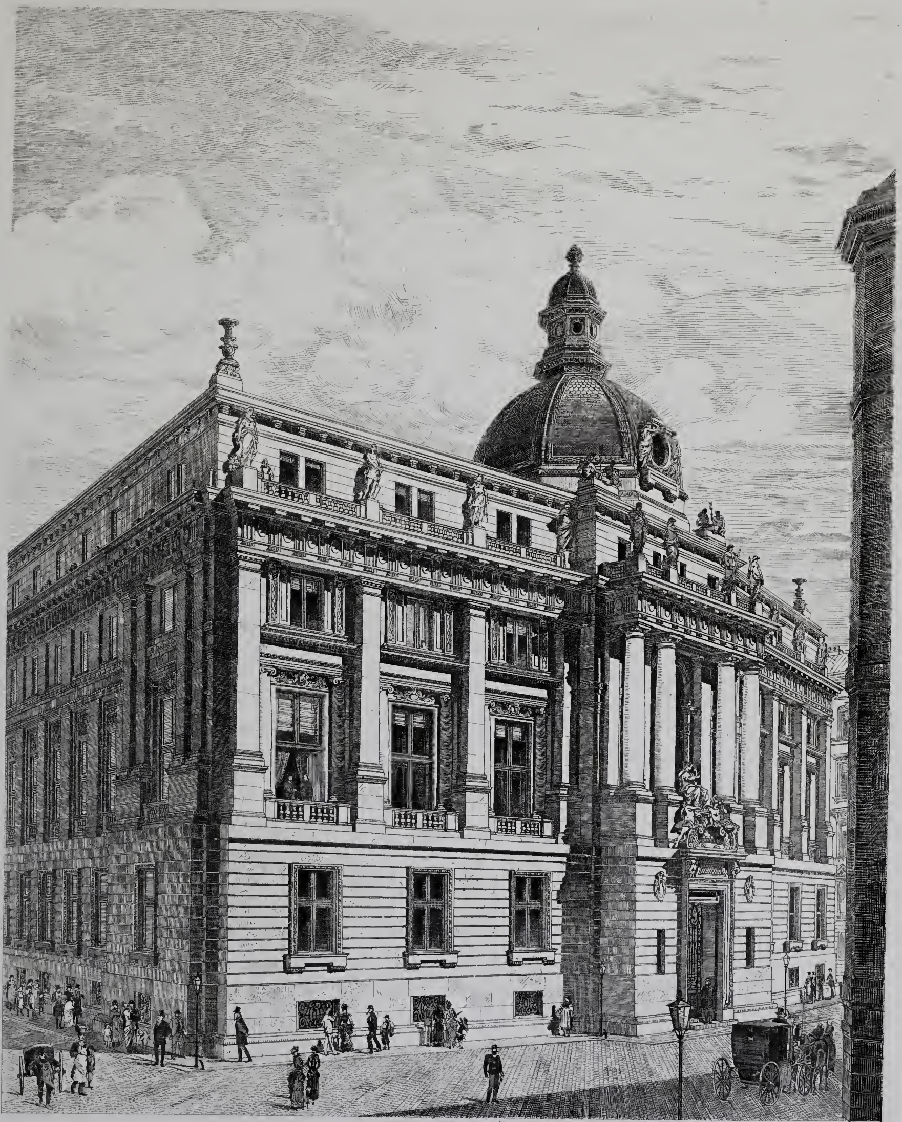
Amtsgebäude der k.k.priv. allgem. österreichischen Boden-Creditanstalt
